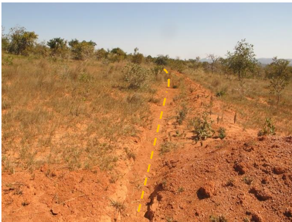
Foto 5: Vista de terraço a ser reconstruído (Coord. UTM 635112 / 7948036) Fonte: Consominas, 2016.
