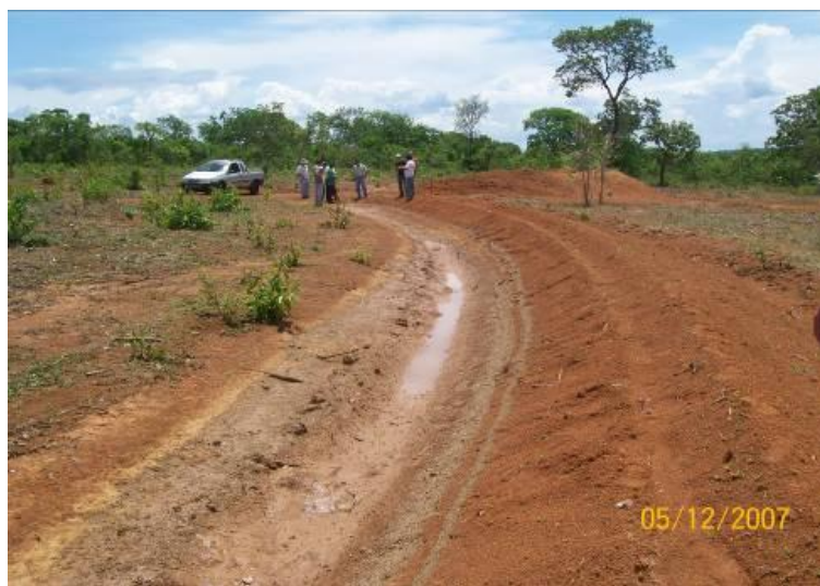
Figura 14: Exemplo de terraço executado
