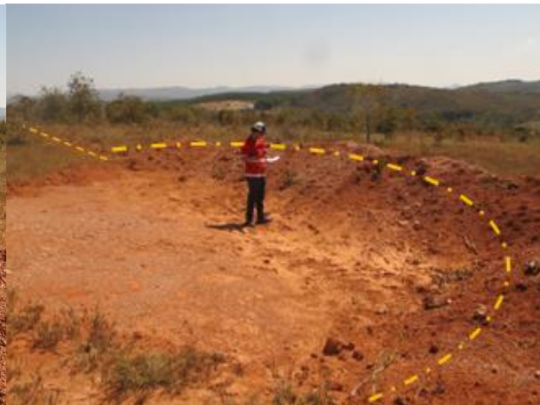
Foto 6: Georreferenciamento da barraginha tipo 2 a ser reconstruída e interligada aos canais coletores dos terraços em curva de nível. (Coord. UTM 635112 / 7948036) Fonte: Consominas, 2016.
